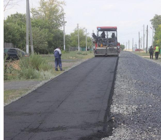
Продолжаются ремонтные работы улиц в селе Егіндік ойыл ского района. Аким района Ерлан Мухамедин ознакомился с ходом асфальтирования улиц в районном центре. Компания-подрядчик ТОО «Gross» провели работы по фрезерованию старого полотна, затем было выполнено устройство выравнивающего и верхнего слоев асфальтового покрытия
